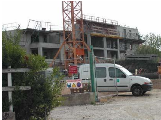
Opération en cours sur Villars les Dombes
